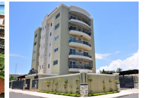
Torre Los Pinos,San Diego,Dominica
